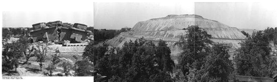
Flakturm nach der Sprengung
